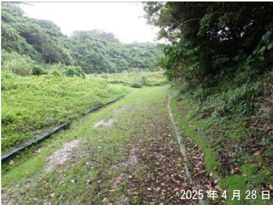
洗掘 3 (旧道路。洗掘補修後に種子吹付け)
